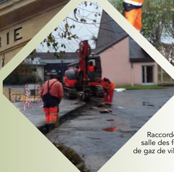
Au centre, remise en état des fontaines
