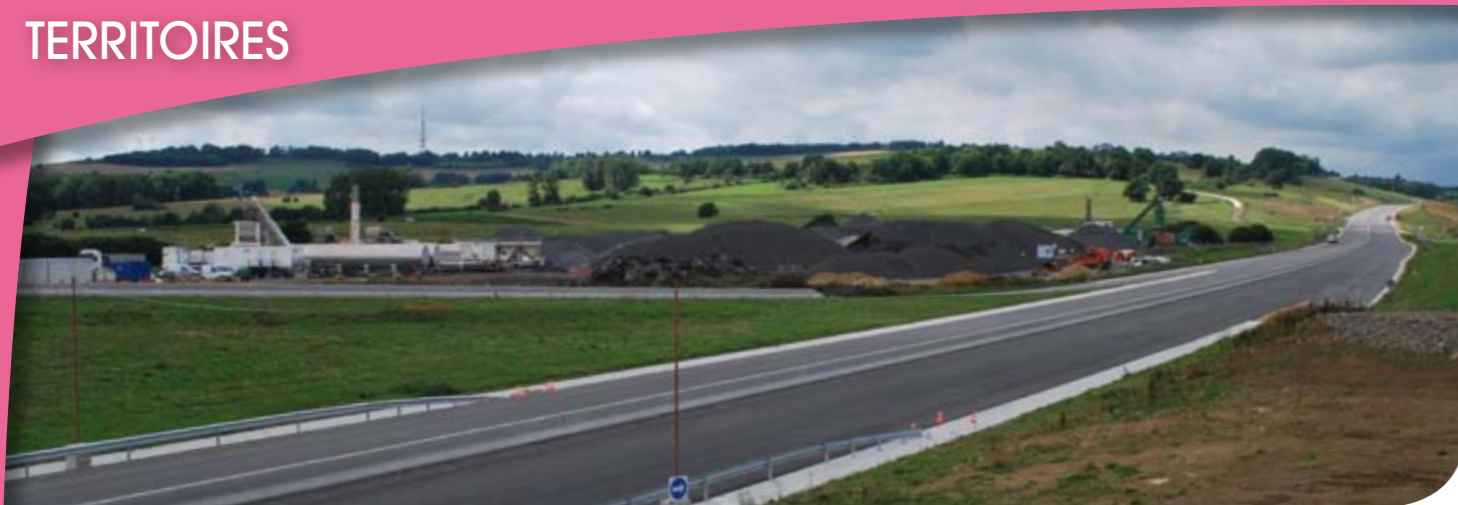
Un premier tronçon de l'A304 a été ouvert fin 2017, le second le sera fin juin 2018
