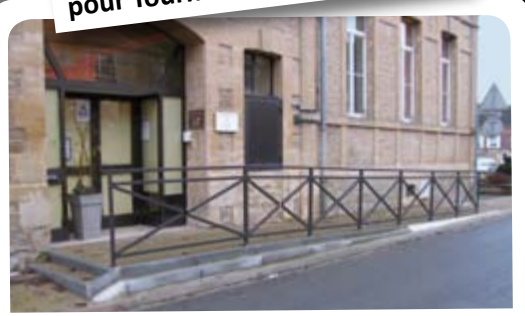
Accessibilité : mise aux normes des bâtiments communaux
