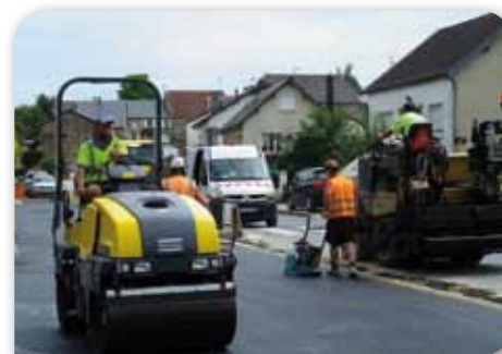
Travaux sur la chaussée
