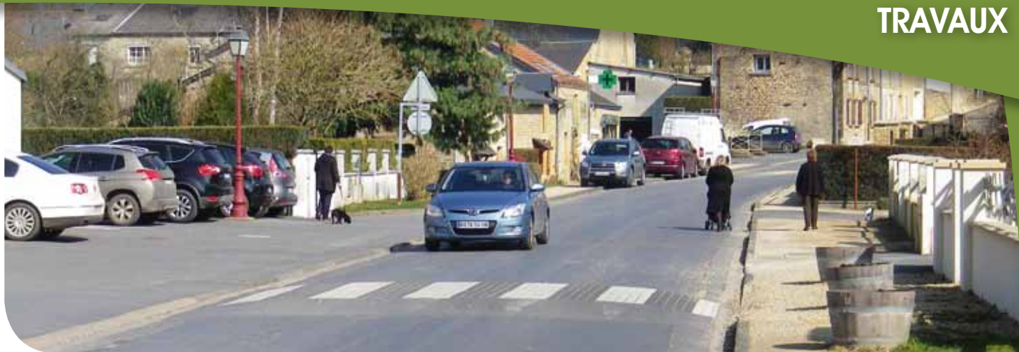
La rue René Dupont avant les travaux
