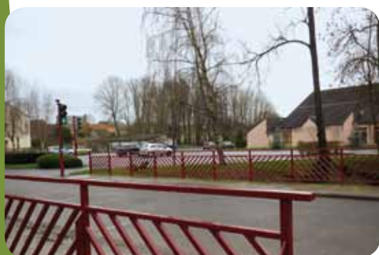
Le pont de la rue du Bois de la Rosière
