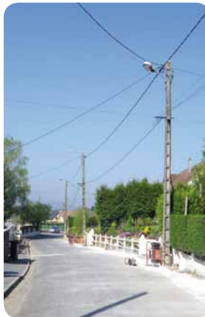
La rue Marcel Fay avant les travaux d'enfouissement ...
