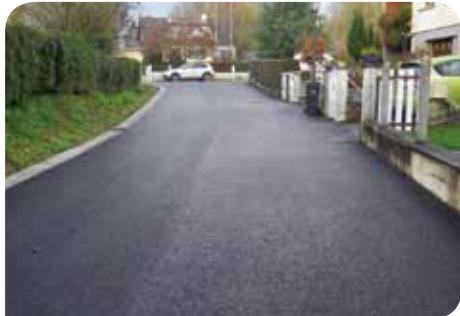
L'impasse du 8 mai a été refaite en même temps que la rue René Dupont. La différence est frappante une fois les travaux terminés.
