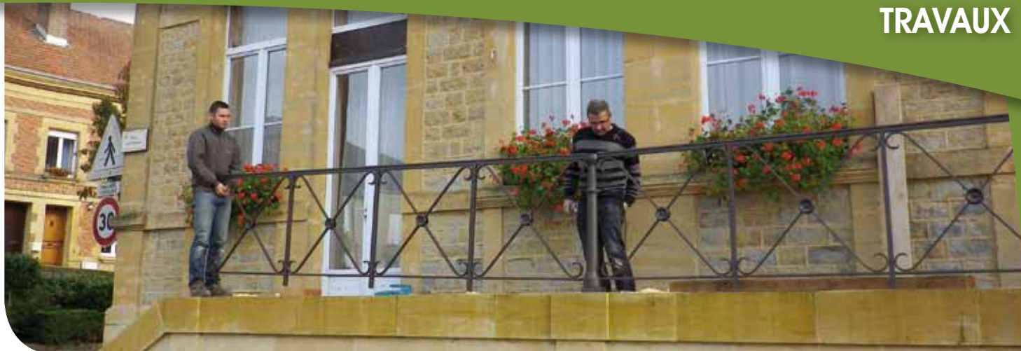
Derniers ajustements, le perron de la mairie est de nouveau accessible après plusieurs mois de travaux.
