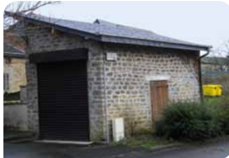
Elle en avait besoin. Chose faite, la toiture du bâtiment communal de la rue des sept fontaines a été restaurée.
