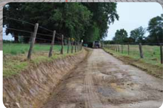
Le chemin du Bois de la Rosière a été entièrement refait
