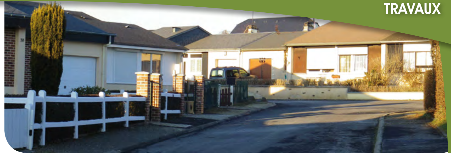
Les travaux de rénovation du Hameau des Fontaines seront engagés en 2017
