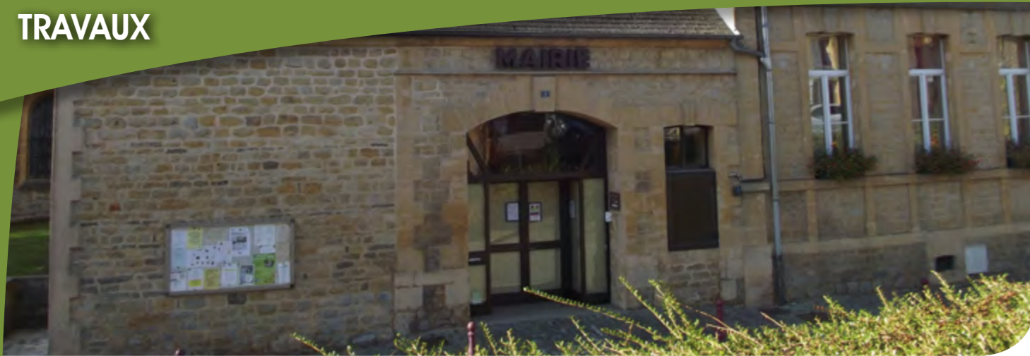
L'étude pour la mise en accessibilité de l'accueil de la mairie a été réalisée
