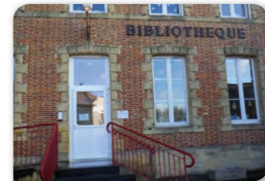
Des travaux d'entretien de la toiture de la bibliothèque seront réalisés en 2017
