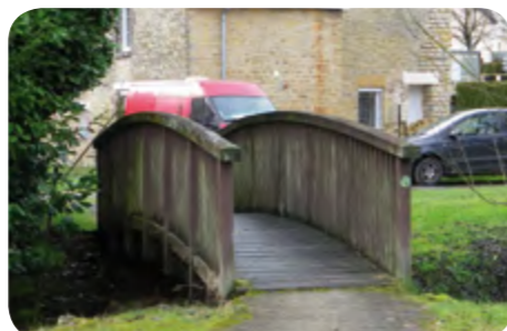
La passerelle Paquis va être rénovée
