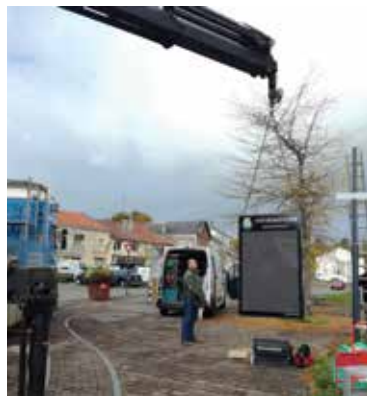
2 - Installation de l'écran
