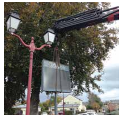
4 - Dépose de l'ancien panneau
