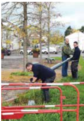
1 - Montage du poteau
