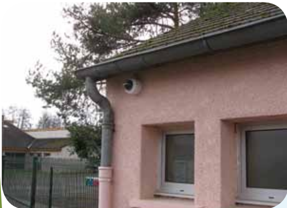
Installation de caméras à la salle des fêtes et à la mairie et d'une antenne relais
