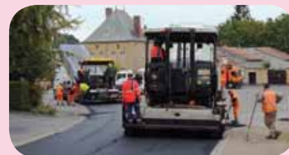
Un chantier rondement mené en moins d'une semaine, occasionnant un minimum de contraintes pour les usagers de cette départementale traversant le village.
