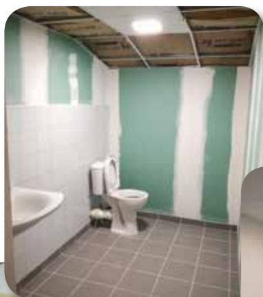
Mise aux normes du sanitaire
