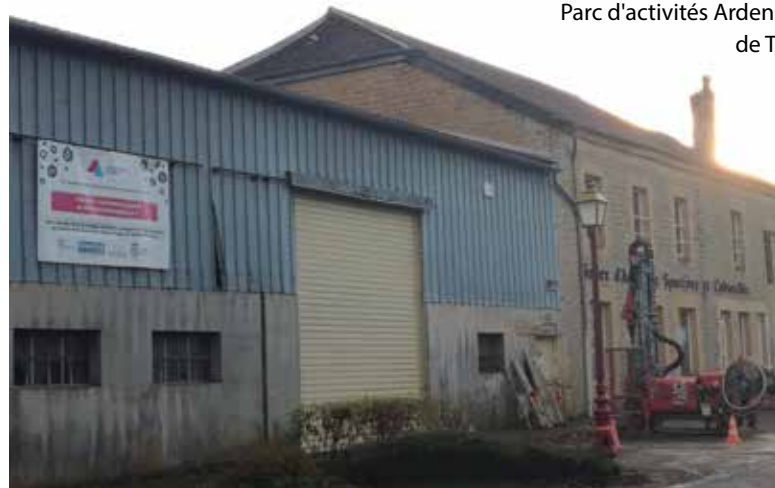
Ce hangar cèdera bientôt sa place à la future maison médicale
