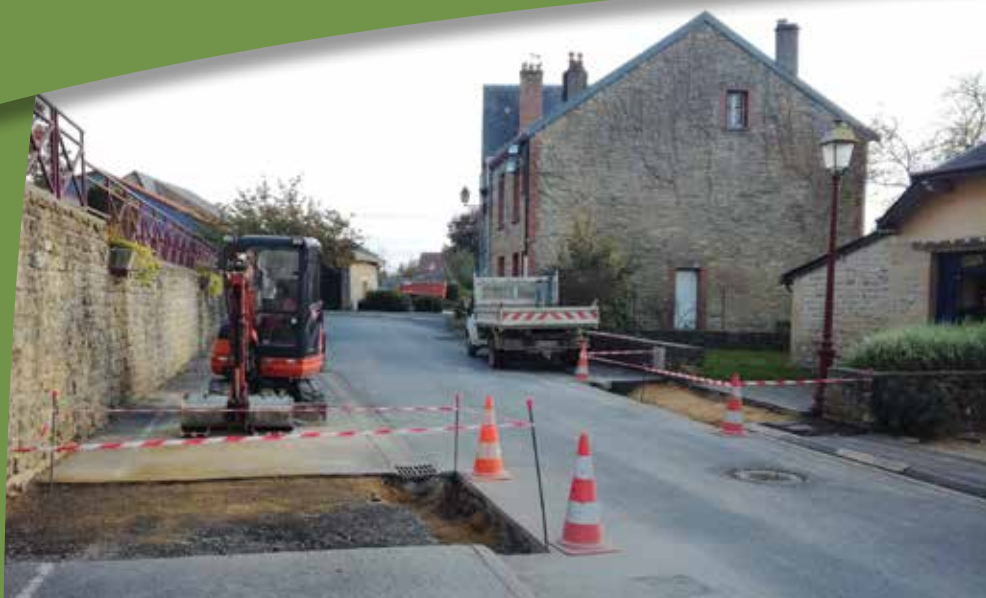
Création d'une place de parking PMR en face de la salle des associations
