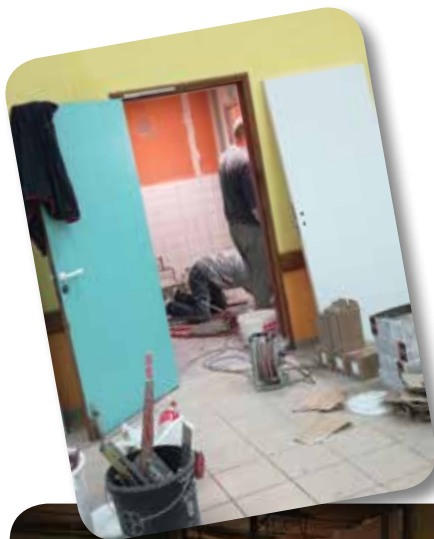
Installation de l'élévateur
