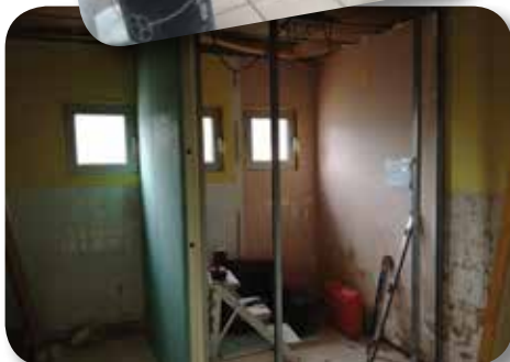
Mise aux normes des sanitaires
